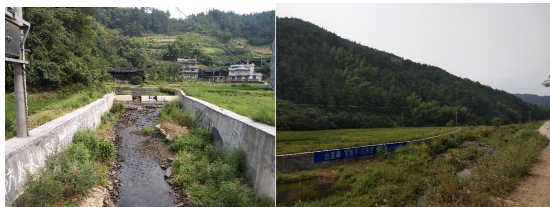
图 1.1-1 岩家垅溪青龙溪村河段已建护岸
